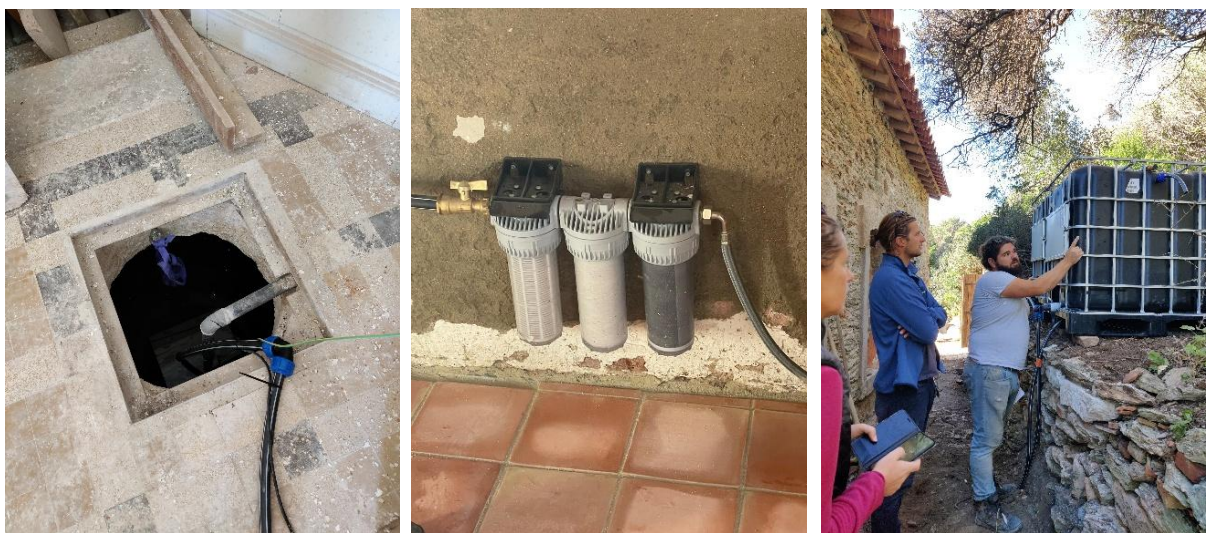
Figure 68 : Raccordement en eau à la maison des gardes et station de filtrage.
