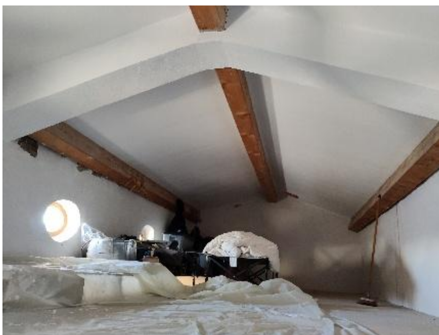
Figure 59 : Mise en peinture du plafond du dortoir.
