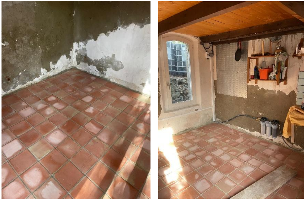
Figure 62 : Pose du nouveau carrelage en tomette dans la cuisine.
