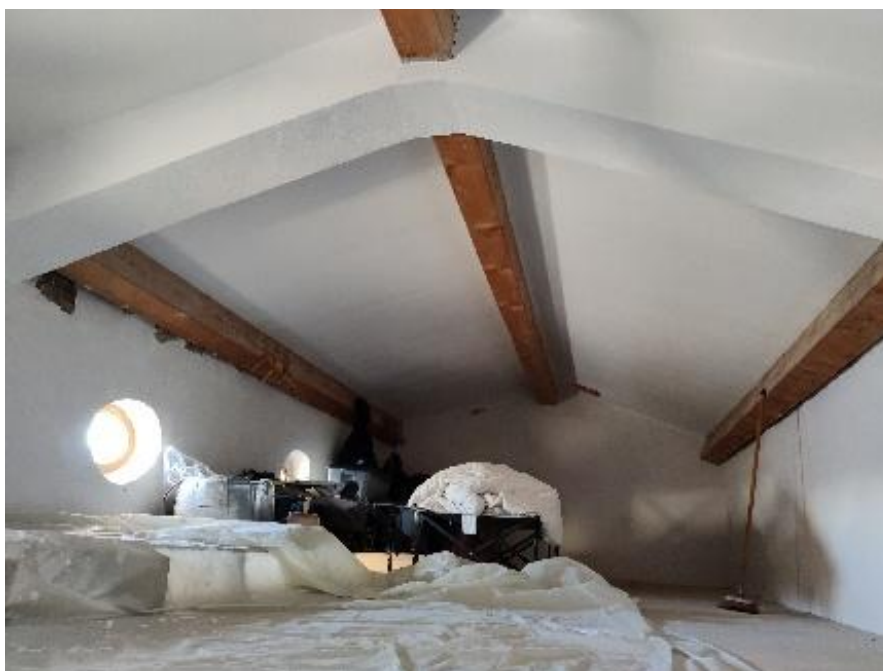
Figure 59 : Mise en peinture du plafond du dortoir.
