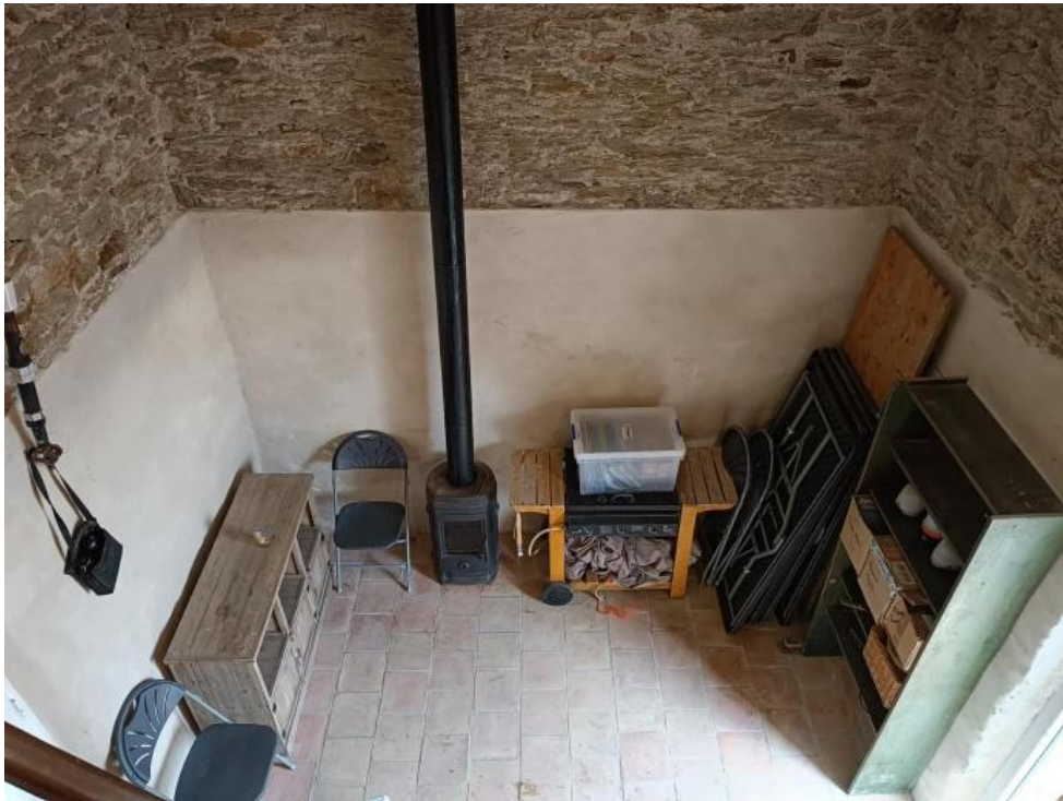
Figure 60 : Enduis jusqu'à 2m de hauteur dans la partie inférieure du dortoir.
