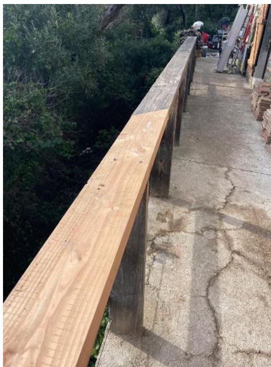
Figure 65 : Section de rambarde remplacée.
