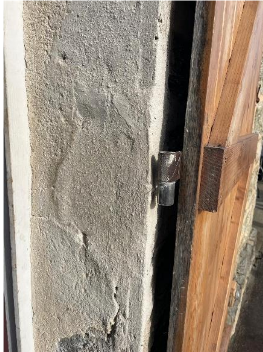
Figure 66 : Nouveaux gonds en inox installés et reprises de maçonnerie.
