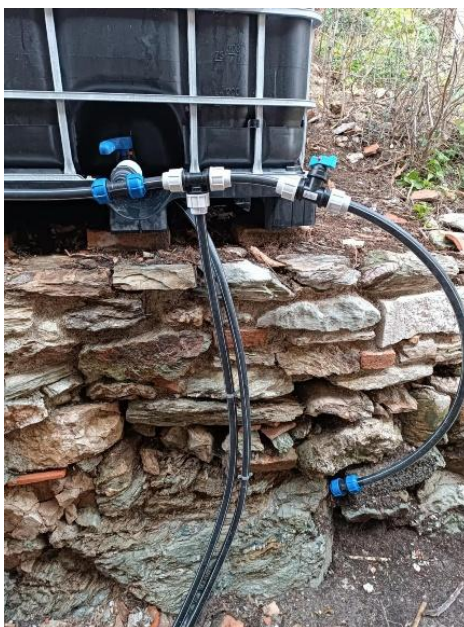
Figure 69 : Raccords de tuyauterie en sortie des cuves d'eau de récupération des eaux de pluie.
