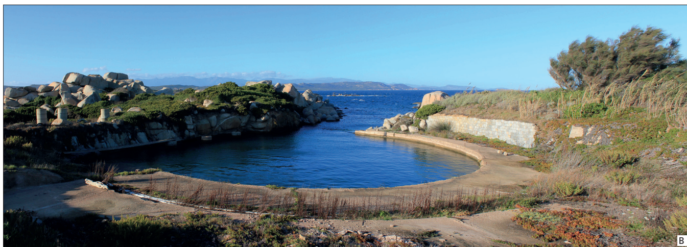
Figure 13 – Paysage actuel de la côte nord de l'île de Cavallo (Cara di Grecu), montrant l'urbanisation diffuse, y compris des constructions inachevées (A), et profonde transformation d'une petite crique en anse totalement bétonnée, à l'extrémité occidentale de l'île, un peu à l'est de la Cara di a Guardia (B) (photos Y. Poher/IMBE).
