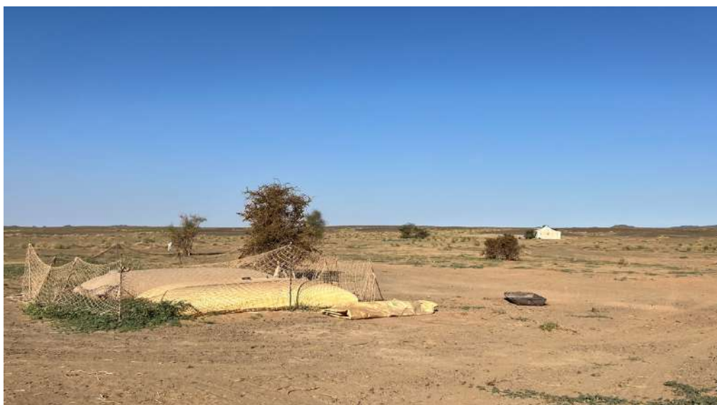
Réservoirs souples près d'une installation semi-permanente. Douyiate Oulad Tidrarine, 16 novembre 2023 (Photo P. Bergier). Les réservoirs sont souvent protégés par des filets pour empêcher les cheptels de les dégrader et les Corbeaux bruns d'y provoquer des fuites d'eau.
