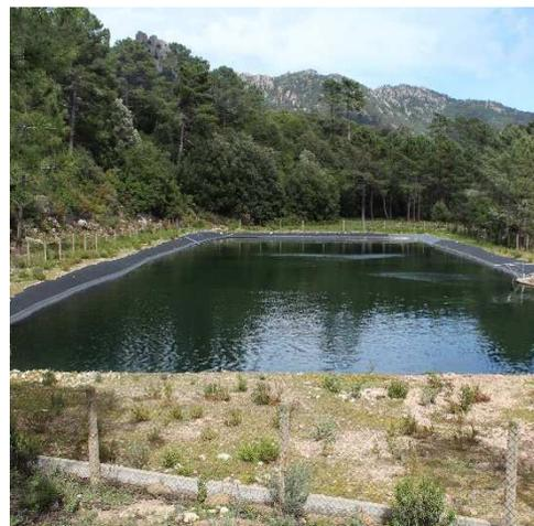
**Réservoir couvert d'une membrane**
