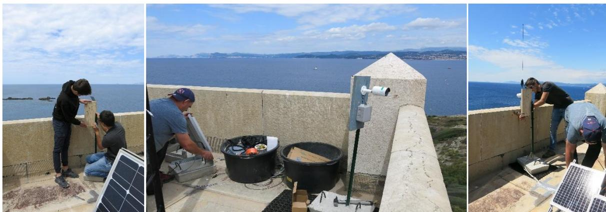
Figure 20 – Installation des caméras Pi-Sigma en haut du phare, sur l'île du Grand Rouveau
