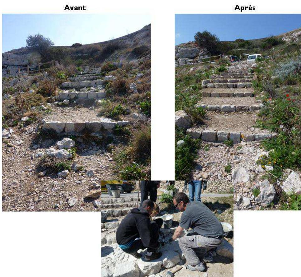
Calanque de Barco Espessado : création d'un sentier d'accès à la calanque par la mise en place d'un escalier en pierres sèches.
