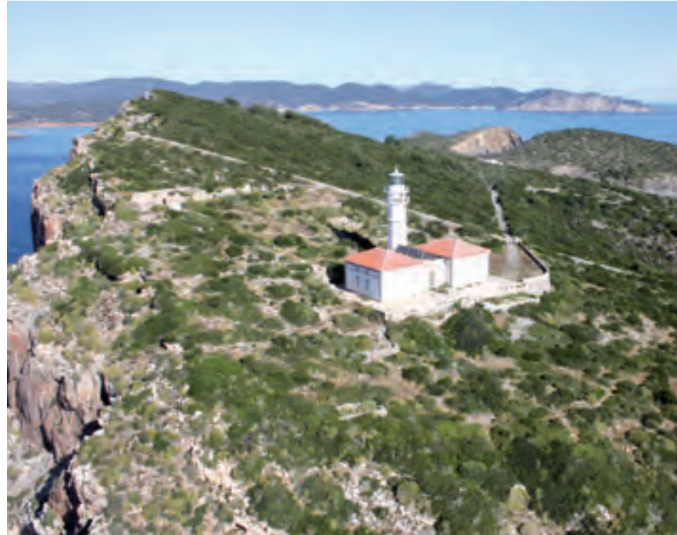
L'extrem oriental de Tagomago està coronat pel far, avui automàtic, però que va ser habitat per dues famílies de torrers fins a l'any 1963. Tot i el valor arquitectònic i patrimonial dels edificis, no s'hi ha fet un manteniment i pateixen un deteriorament progressiu.
