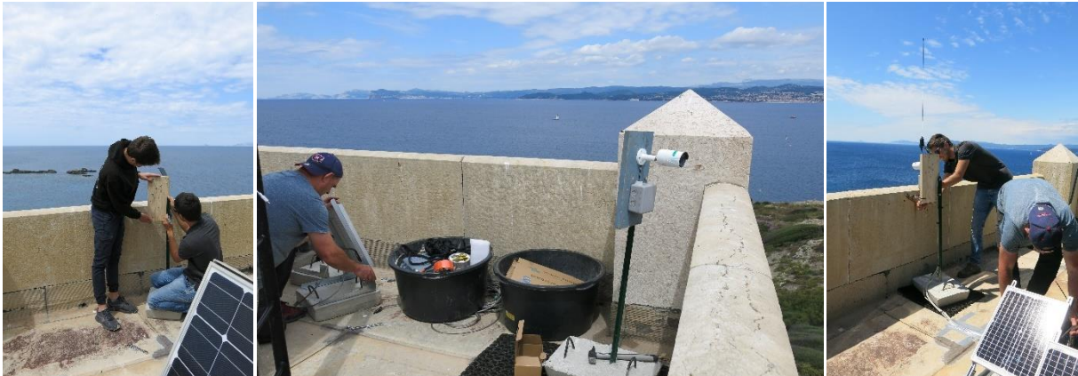
Figure 21 – Installation des caméras Pi-Sigma en haut du phare, sur l'île du Grand Rouveau
