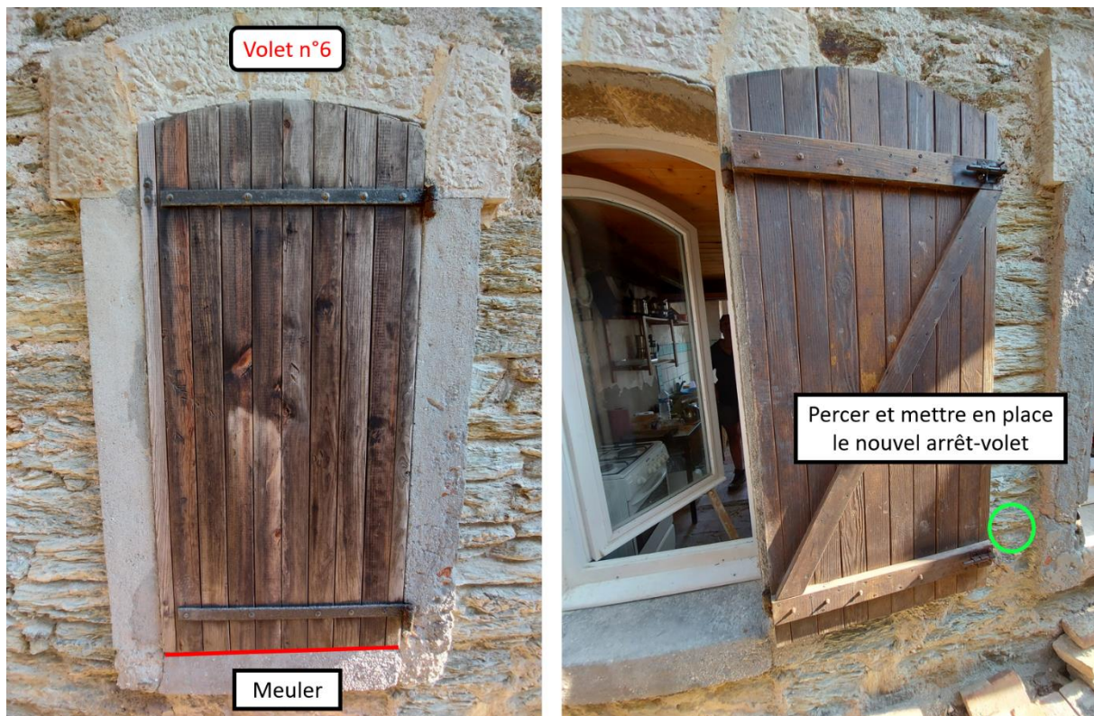
Figure 29 - Illustration des travaux à faire sur le volet n°6
