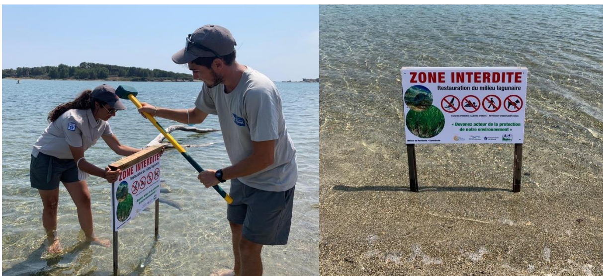
Figure 22 – Installation de la nouvelle signalétique dans la lagune du Brusç, île des Embiez
