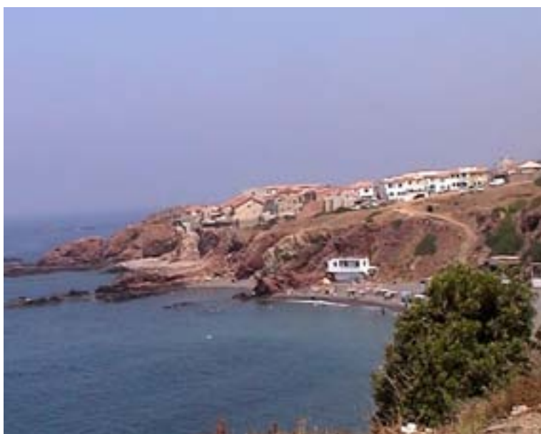
Une urbanisation irréfléchie de l'espace littoral générant des altérations et dénaturation des caractéristiques originelles de l'espace littoral de la zone de Chenoua.
