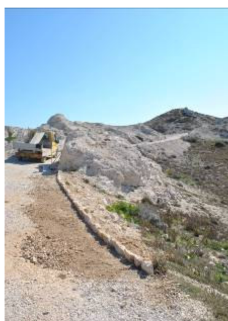
- Secteur Calanque de l'Huile : Mise en place de 17m de pierres plantées sur chant le long de la piste de Pomègues
