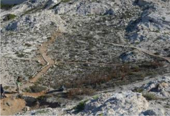
- Calanque du Grand Soufre : réaménagement du sentier d'accès à la calanque du Grand Soufre par le plateau de Brigantin
