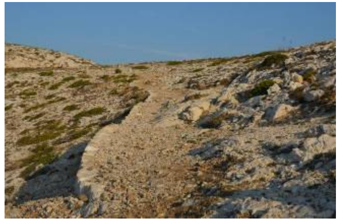
- Secteur Calanque de l'Huile : Mise en place de 17m de pierres plantées sur chant le long de la piste de Pomègues
