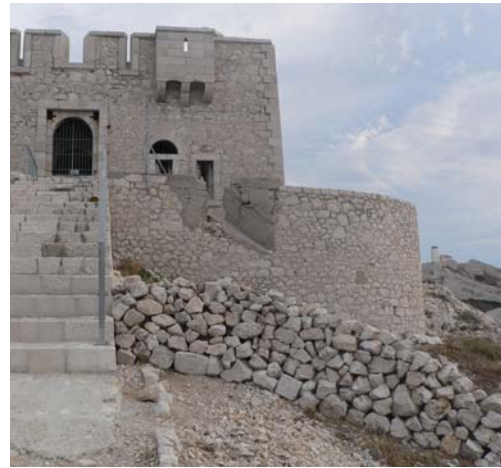
Tour de Poméguet : après aménagement
