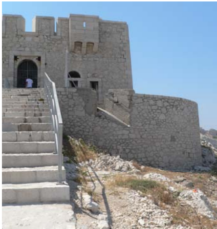
Tour de Poméguet : avant aménagement
