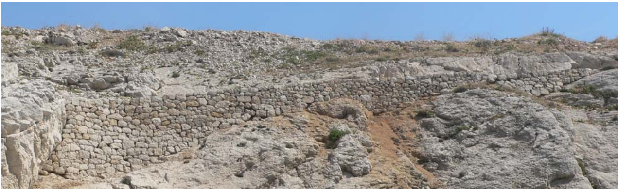
Mur de soutènement de la calanque de Morgeret
