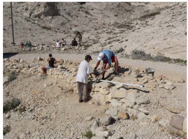
Restauration du mur de soutènement de la piste du Port de Pomègues
