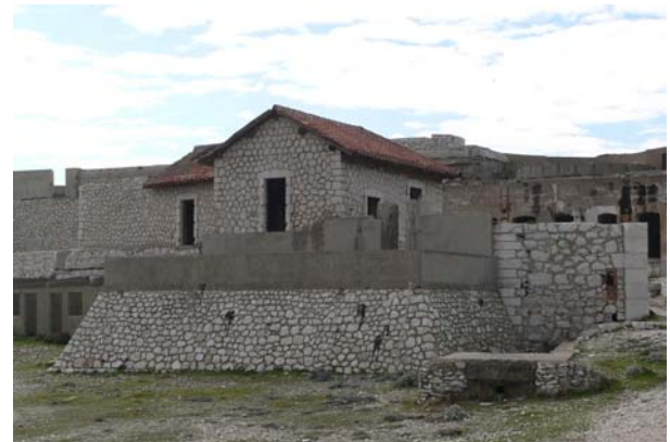
Citerne de Cavaux après travaux
