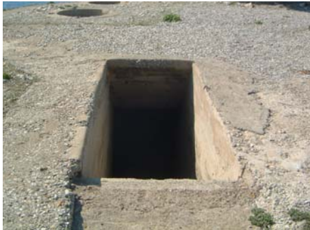
Escalier d'accès aux soutes à munitions avant mise en sécurité
