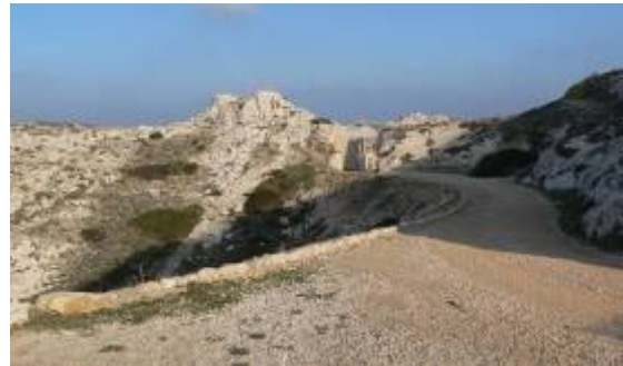
Après pose de pierres plantées
