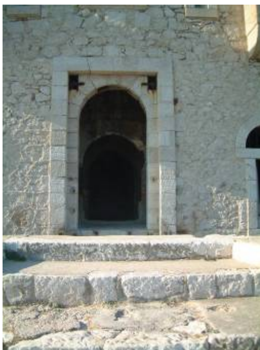
Entrée de la Tour avant aménagement
