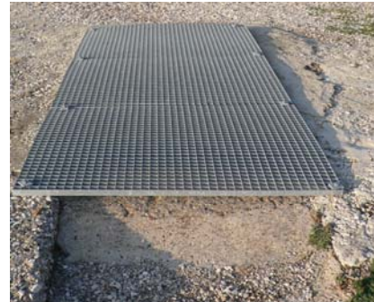
Escalier d'accès aux soutes à munitions après mise en sécurité
