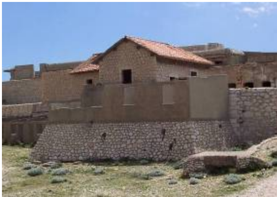
Citerne de Cavaux avant travaux
