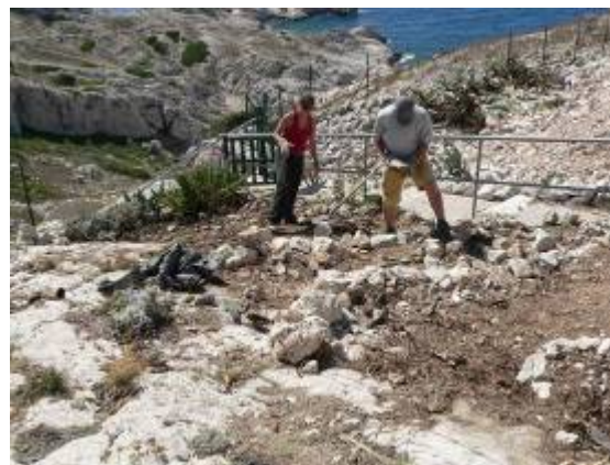
Restauration des restanques
