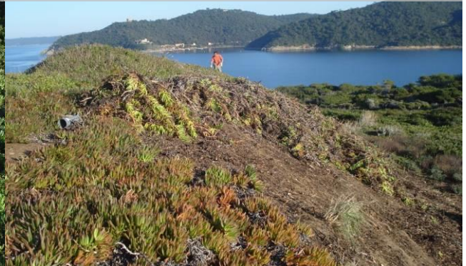
Pose d'un géotextile
