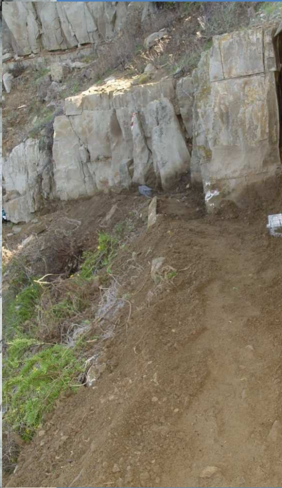
réalisation de chemins
