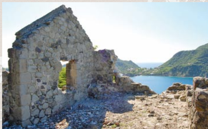
Les ruines du fort Joséphine
