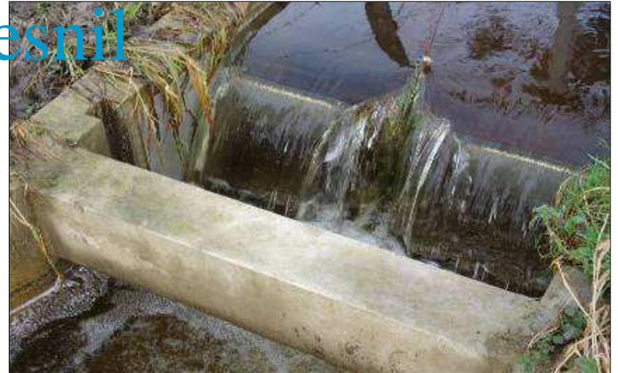
Dispositif du contrôle des niveaux d'eau
